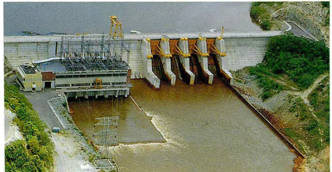
Stesen hidro elektrik Bersia di Perak.
