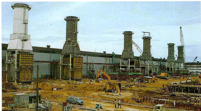
Stesen Janaelektrik Paka di Terengganu dalam pembinaan.
