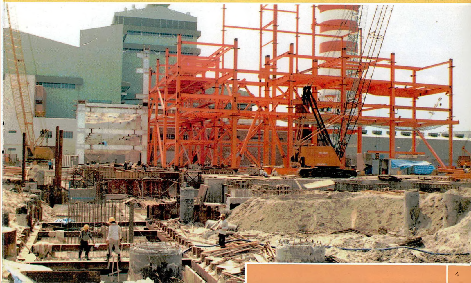
Kerja-kerja awam sedang dijalankan di tapak pembinaan Stesen Janaelektrik Fasa II.
