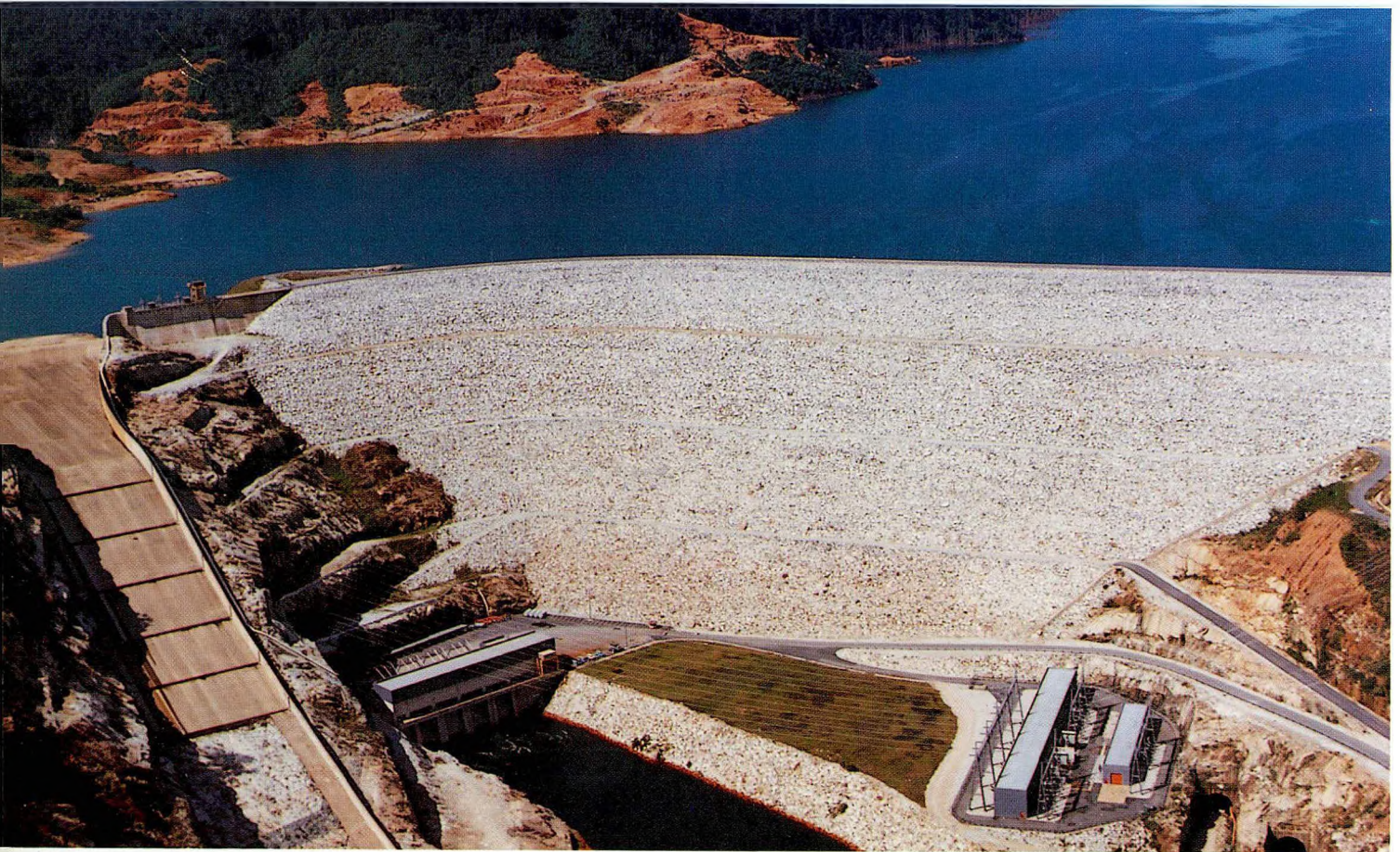
Stesen Janaelektrik Hidro Kenyir, Terengganu dengan keupayaan 400 MW.
